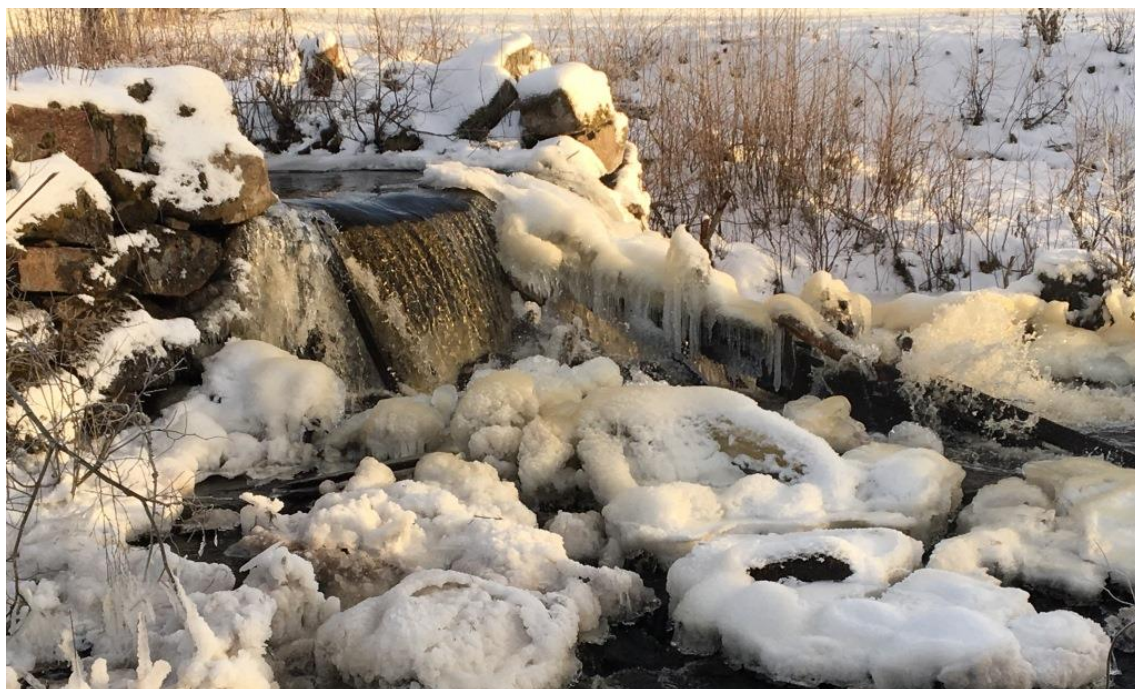
Första vandringshindret vid Gällserud ca 2,4 km från mynningen i Övre Fryken. Den raserade fiskvägen i trä är helt omgiven av is. Fallet är ca 1,2 m högt och ett definitivt vandringshinder för fisk. Uppströms resterna efter dammen finns ingen vattenspegel, dvs resterna har inte längre en dämmande effekt.
